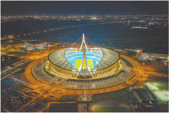
这是9月9日在金边拍摄的柬埔寨国家体育场(航拍照片)。中国援柬体育场是迄今对外援助规模最大、等级最高的体育场。体育场整体呈帆船造型,设计吸收了古代吴哥窟建筑工艺精髓,同时使用中方自主研发的一流工艺技术,实现了绚丽多姿的高棉文化同中国“大国工匠”精神交相辉映的完美融合。(新华社发)
