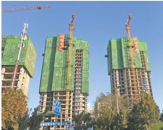
金地广场施工现场。 史凯 摄
