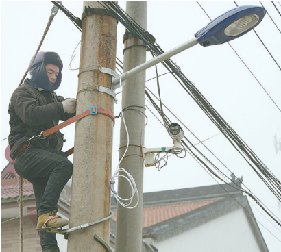
1月10日，温县供电公司工作人员在为温泉街道门庄村维修和安装路灯。入冬以来，该公司投资100余万元，用于全县262个行政村村路线路的架设和维护，目前已完成93个台区相关线路线路的架设任务，为辖区群众欢度新春佳节提供了有力保障。
