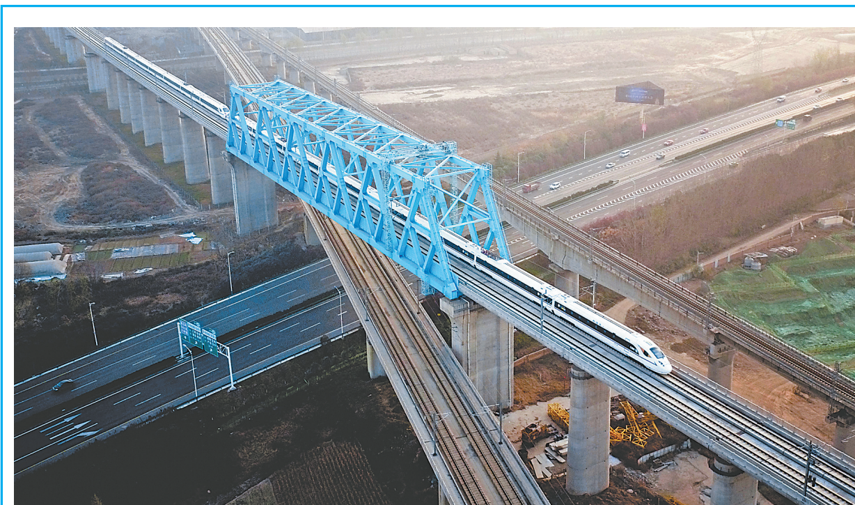
12月6日，西成高铁由西安北站驶出的列车经过西成高铁跨西宝高铁特大桥。该桥是出西安北站的第一座特大桥。 当日，西安至成都的高铁列车呼啸着穿过秦巴山脉，开辟了中国西部发展新格局；西北西南快速通联，推动中国南北交通格局之变；5万亿元经济总量的“成渝西”城市群浮出水面，带动西部经济格局之变；中国涉及省份最多的秦巴山集中连片贫困区串起高铁扶贫路，催生西部人民精神面貌、发展理念之变。 刘 潇 摄（新华社发）
