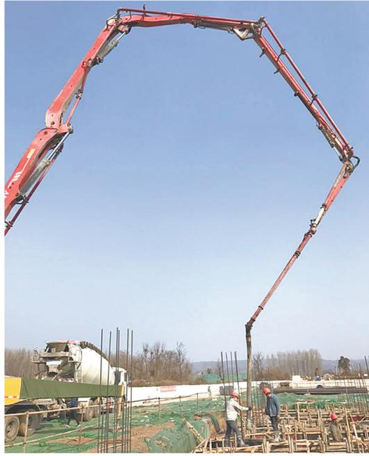
3月7日上午,在府城水厂建设工地,工人们在进行混凝土浇筑作业。 袁丽 摄
