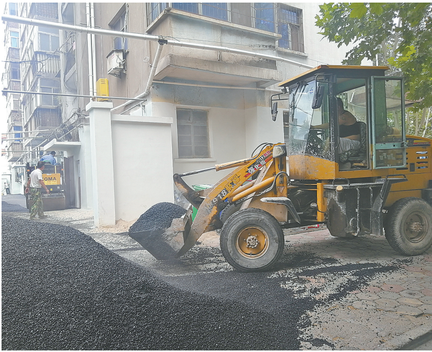
绿化队楼院铺设沥青路面现场。
