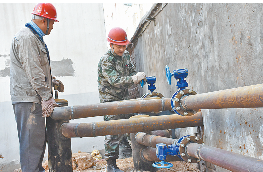
河海新能源股份有限公司施工人员在调试供热管道。 赵春营 摄
