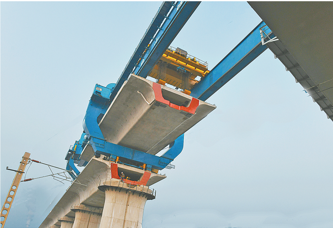
2月10日，太焦铁路施工现场，中铁七局郑州公司施工队正在吊装箱梁。为了保证太焦铁路施工进度，该公司发扬连续作战的作风，加班加点赶工期，奋战在工地一线。截至目前，该公司已完成吊装箱梁196片，计划在5月中旬完成全部吊装任务。
