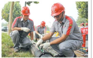
应急演练中,工作人员截取更换被第三方破坏的燃气管。
