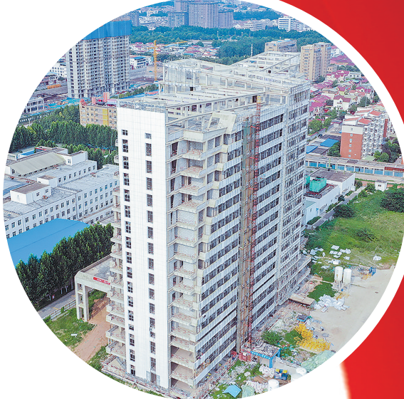
全市人民关注的沁阳市人民医院病房楼建设加快推进。图为施工现场。
