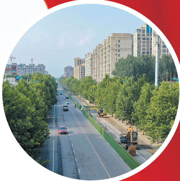
沁阳市城区集中供热工程加快推进。图为施工现场。
