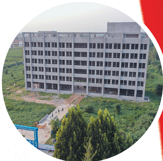
沁阳市妇幼保健院异地新建大楼加快建设。图为施工现场。
