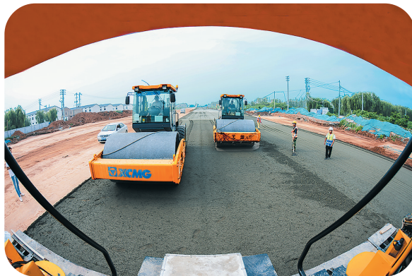
市东海大道建设项目施工现场,中建三局施工队在加紧摊铺水泥稳定碎石基础。
