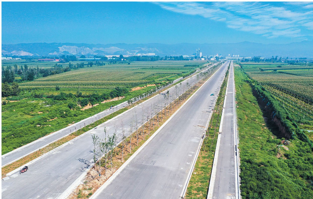
已经完成的一段部分绿化带工程。
