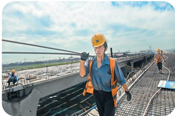
中建三局施工队员在向工地运送钢筋。
