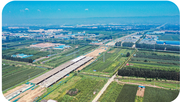
已经完成箱梁吊装的市东海大道跨新河桥。
