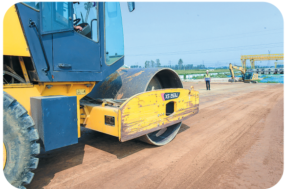
中建三局施工队压路机在碾压路面基础。
