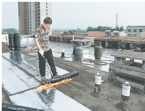
9月10日，市住房保障中心焦东房管所施工人员在民馨苑廉租房小区实施楼顶防水作业。截至目前，该所已实施楼顶防水作业近600平方米。 本报记者 刘金元 摄
