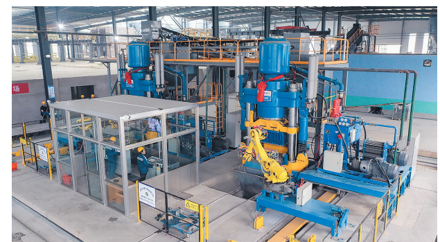
沁阳泓都粉煤灰项目从建厂到投产仅用202天,实现了当年开工、当年投产,创造了喜人的“泓都速度”。
