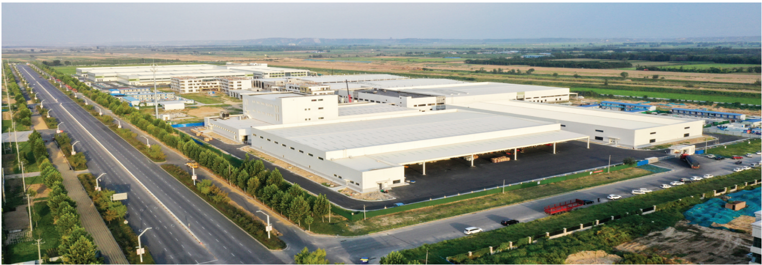
大咖食品有限公司高标准厂区及配套基础设施。
