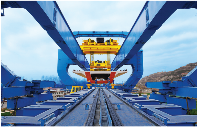
架桥机在进行铁路箱梁架设。
