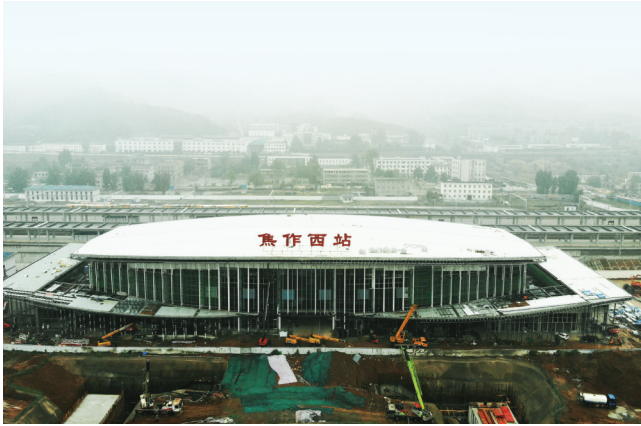
即将投入使用的焦作西站。 本报记者 翟鹏程 摄
