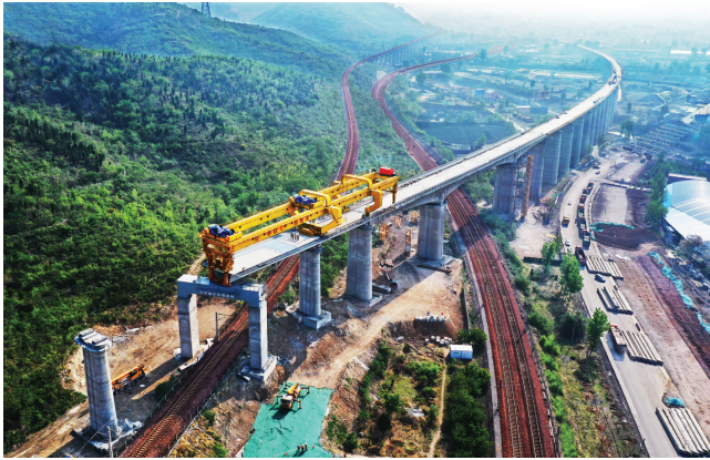
运架一体机在进行架梁作业。
