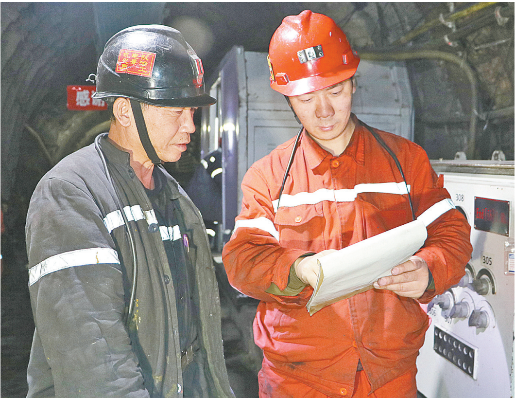
进入四季度以来,焦煤集团中马村矿从加强各类机电设备的维护管理,采取检查与检修、排查和整改同步走的方式,提高设备运行效率,确保安全生产。图为昨日该矿安监人员在井下3906工作面对照规程检查设备运行情况。
