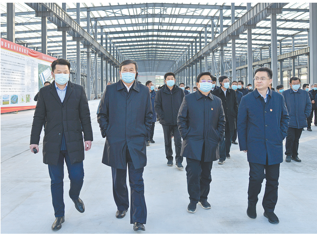
市委书记王小平，市委副书记、市长徐衣显在位于武陟县的长沙远大住宅工业集团股份有限公司远大住工CPS河南研发生产总部基地项目建设现场观摩。 本报记者 翟鹏程 摄
