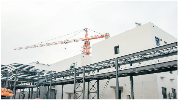
建设中的和兴化工导电炭黑项目。
