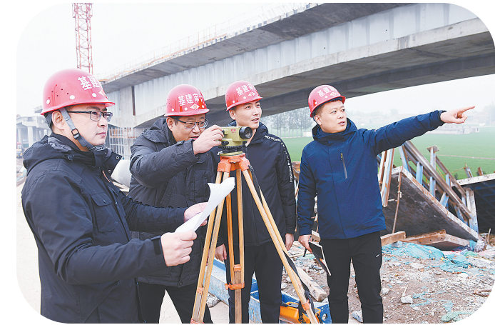
▲市审计局审计人员在国道207（原S237）焦作至温县段改建工程现场查验工程进度。 本报记者 刘金元 摄
