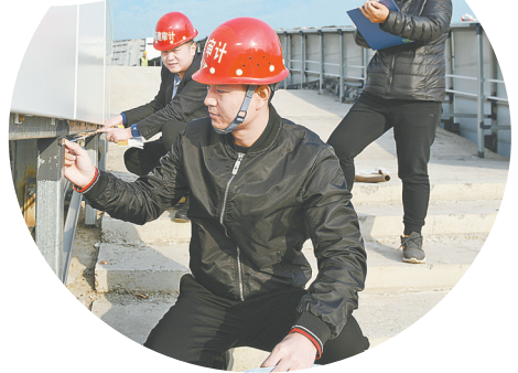
▲市审计局审计人员在南水北调焦作城区段生态保护PPP项目纪念馆工程现场，核查工程量。 本报记者 刘金元 摄
