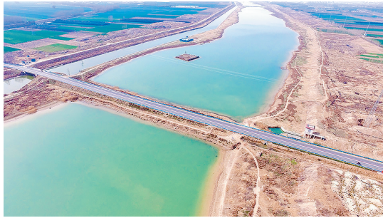
“四好农村路”跨越大沙河。
