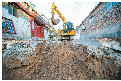
加快农村污水管网建设。
