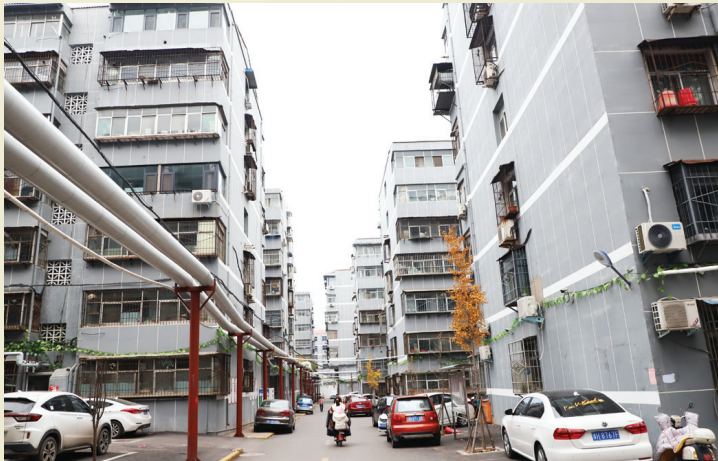
整改后的老旧小区焕然一新。
