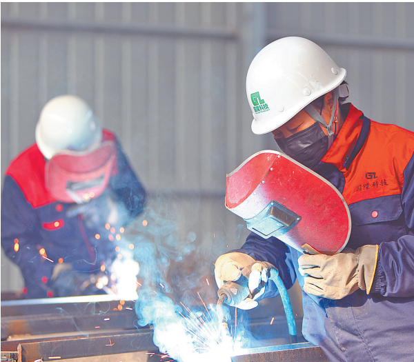
4月7日，马村区国隆科技股份有限公司项目施工现场，一派热火朝天的建设景象。项目建设是经济工作的关键切入点和主抓手，一直以来，马村区牢固树立“抓项目就是抓发展”的理念，始终将项目建设牢牢抓在手上，不断解放思想、强化措施，千方百计破解项目难题，为全区经济持续高质量发展提供了强力支撑。
