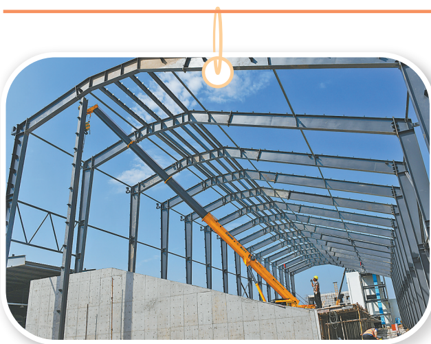
9月10日,在焦作安彩新材料有限公司项目建设现场,施工队正在安装钢结构厂房。该公司位于博爱县产业集聚区,总投资7.96亿元,将建光伏玻璃窑炉、光伏玻璃原片生产线等,计划今年10月建成投产。
