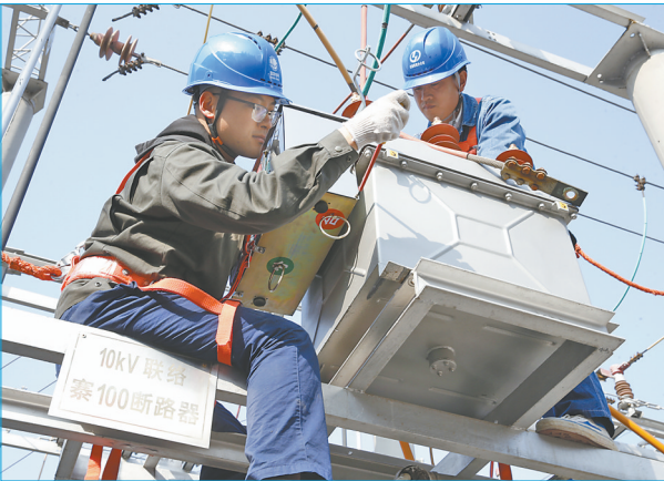
近日，博爱县供电公司员工在对10千伏联络寨100断路器进行更换。为提高电网供电能力和供电可靠性，连日来，该公司实施了35千伏寨窝变电站10千伏东西母线断路器技改工程。程 刚 摄
