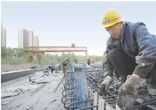
4月18日下午,在河南省林邓线焦作市界至月山段第五合同段箱梁预制厂,工人正在为大石河桥预制桥梁板。目前,大石河桥下部工程已完成,桥梁上部工程的梁板预制及安装已全面展开,预计今年8月底可投入使用。本报记者田建明 杨铭 摄
