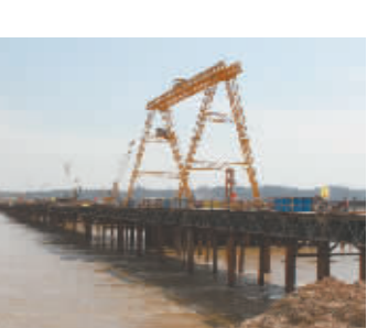
主桥施工井然有序。章一平 摄
