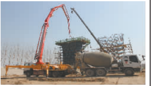
墩身施工稳步推进。李向敏 摄
