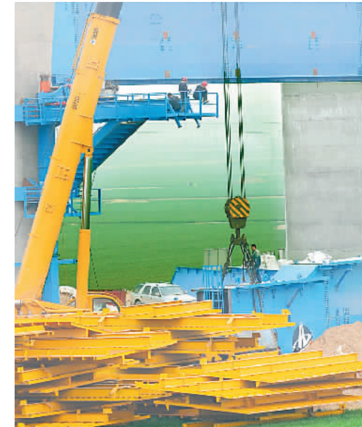
昨日上午,武(陟)西(峡)高速公路黄河桃花峪大桥四标段施工人员正在紧张施工。该工程计划于2013年4月完工，目前已完成基桩431根。
