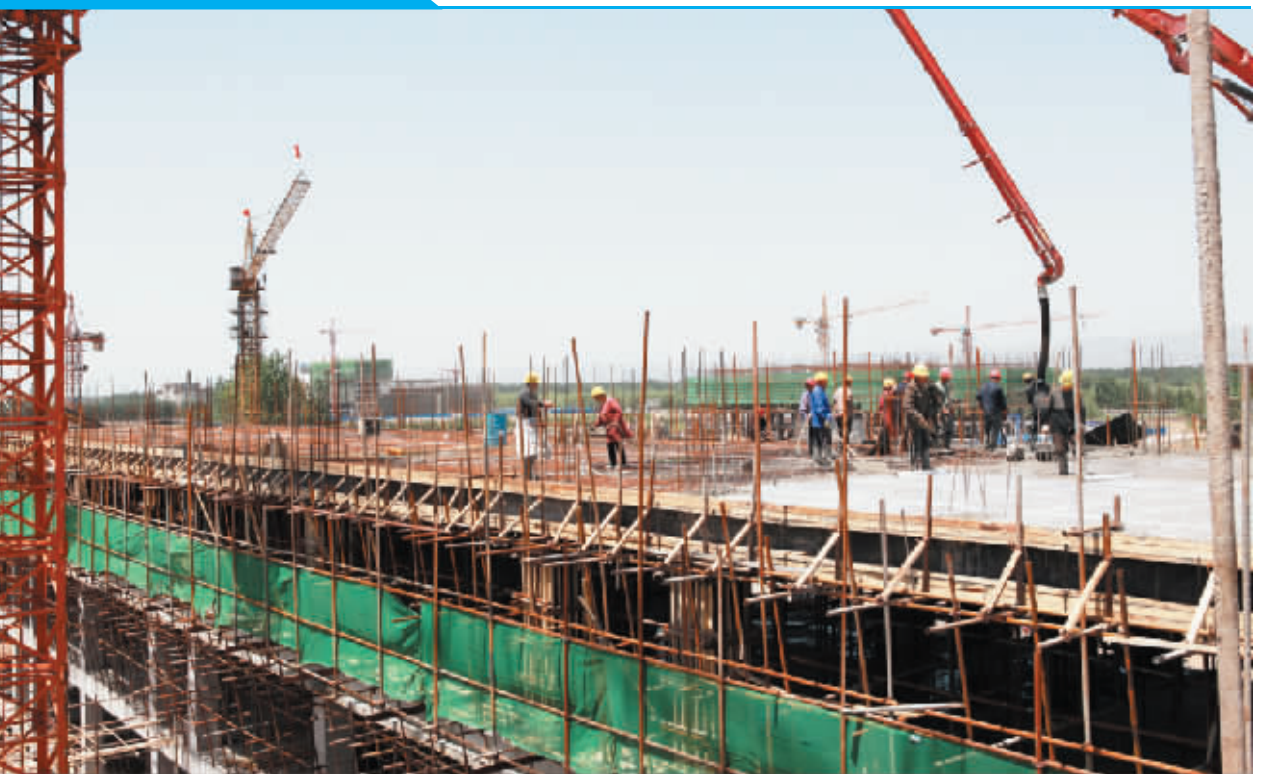
5月12日12时许，北大附中河南分校焦作校区项目建设工地的工人们正在加紧施工。今年1~4月份，该项目已累计完成投资7000万元，目前校区内宿舍楼、食堂、中学教学楼、幼儿园等多栋建筑正在紧张的施工中。今年9月，该校即可迎接新生入校。
