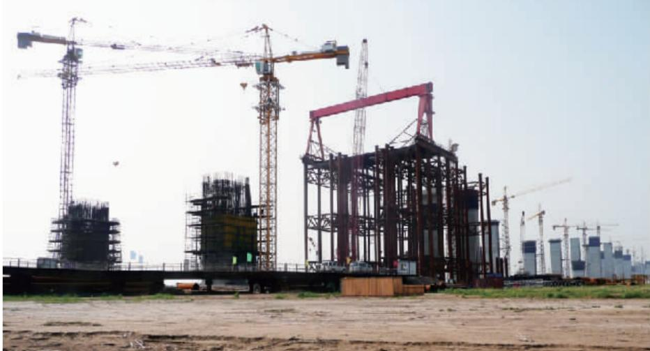
5月7日下午，武西高速桃花峪黄河大桥钢箱梁2—170吨移动式提梁站成功安装。此举为主桥首片钢箱梁顶推扫除了起吊障碍，标志着主桥施工又迈入一个新的阶段。
