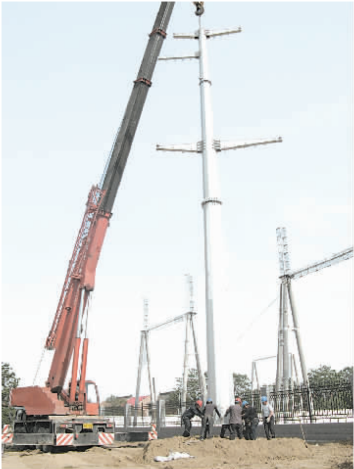
孟州市电力公司为加快电网升级步伐, 放弃节假日, 组织人员、车辆投入到集聚区中内配110千伏输变电工程施工中。图为5月14日施工人员在吊装耐张杆塔。陈树德 摄
