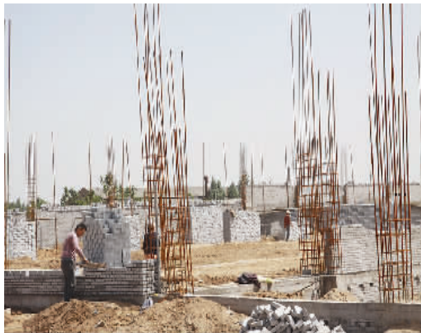
5月12日,河南明翔肥业有限公司年产17万吨生态复合肥项目正在施工。为推进产业集聚,温县在产业集聚区规划建设了小型企业创业园,鼓励小企业、小项目入驻发展。目前,已有安洋机床、永昌药用包装材料、明翔复合肥等7个项目入驻创业园。 王红亮 摄
