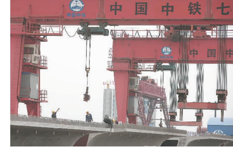
5月31日,中铁七局郑焦城际铁路工程修制梁场的员工正在160吨龙门吊现场施工。该制梁场位于修武县小营工业区,承担着郑焦城际铁路工程建设期间黄河以北以及黄河以北引桥的所用箱梁预制工作,将预制箱梁486孔,其中24米箱梁14孔,32米箱梁472孔,合同总价约3亿元。
