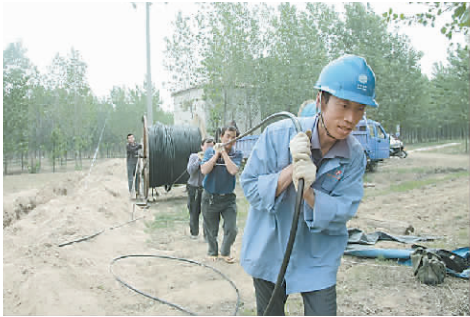
5 月 30 日，在温县林业局实验林场“农网井井通电”项目施工现场，工作人员正在放线。该工程 6 月底结束后，县实验林场 3660 亩黄河滩区林地将具备井井通电的条件。 王红亮 李拥军 摄
