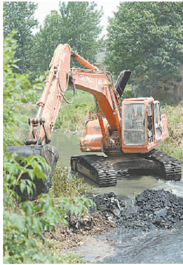
↑中站区民兵应急连组织挖机在普济河中段险工处施工。
