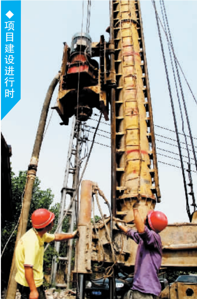
6月13日，常绿集团综合开发项目建设工地的工人们正在进行打桩前的准备作业。该综合开发项目占地93.48亩，总投资6.5亿元，建成后将进一步提升新区的城市形象和城市品位。 席援朝 摄
