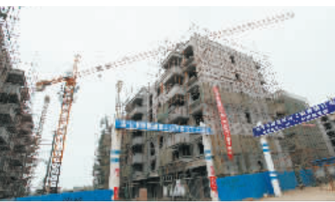
图为正在建设中的朱村美苑。
