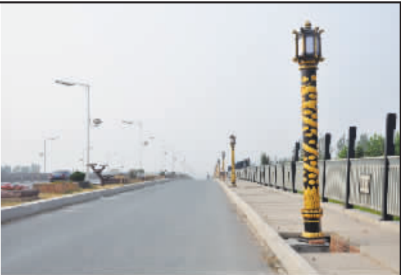
古典景观灯,位于迎宾路大沙河桥两侧,高4米,灯杆、灯头均采用铸铝工艺,灯杆表面龙腾图案采用描金处理,凹凸有致,栩栩如生。
