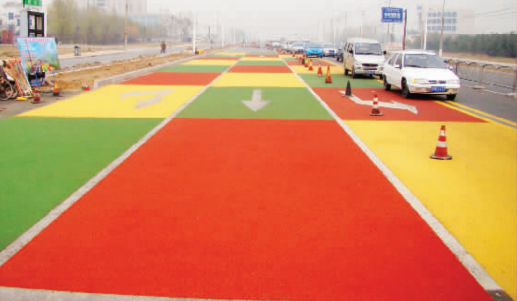
河南新时代交通发展集团有限公司在迎宾路改造工程中实施彩色路面摊铺,开了全省城市道路铺设彩色路面的先河。
