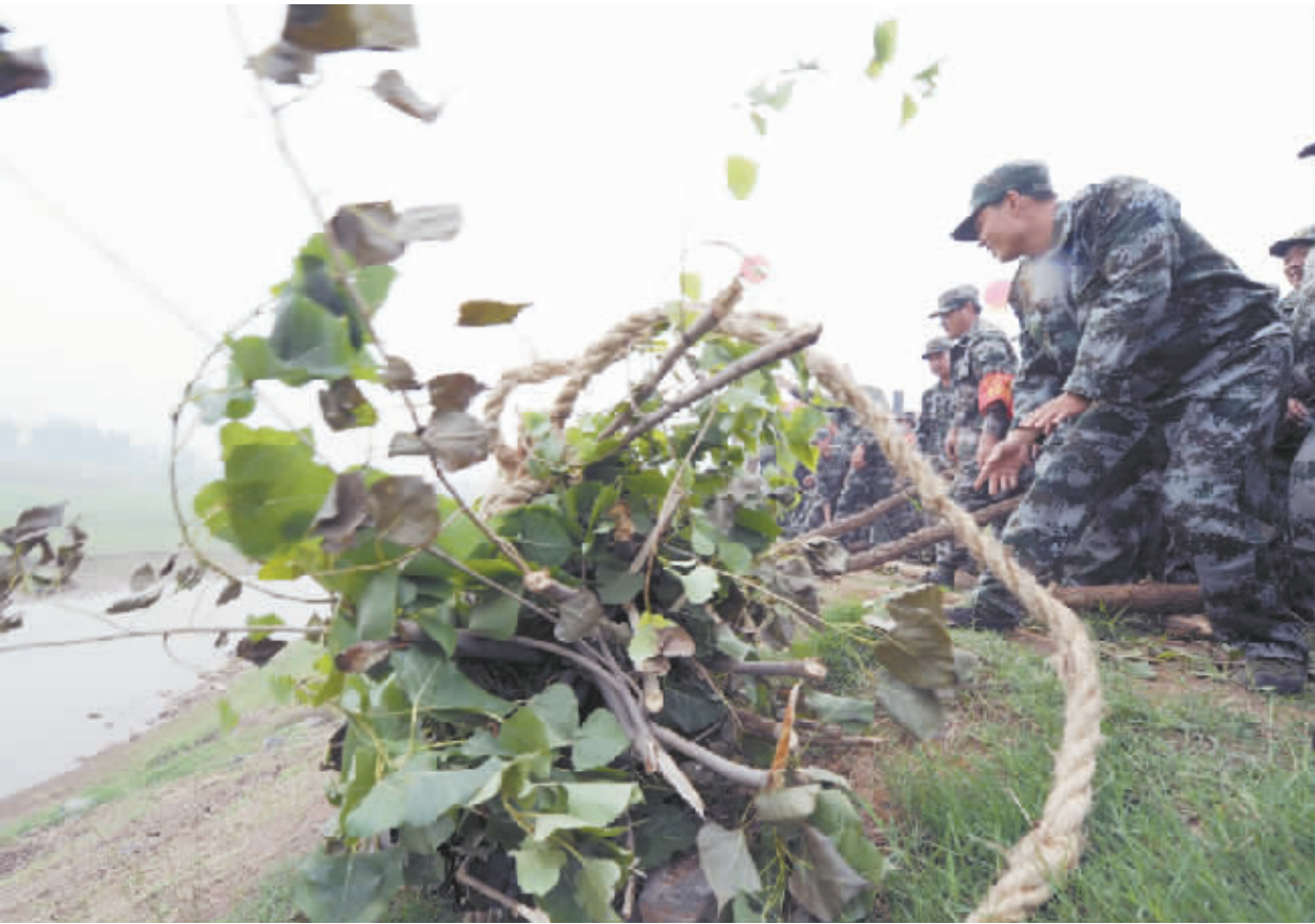
7月13日,沁阳市举行沁河防汛实战演练,由当地驻军、民兵预备役人员、黄河专业抢险队员、公安民警、医护人员组成的近千人的抢险队伍,参加了捆抛柳石枕、人工打桩、抢修子堤、水上救援、迁移安置等项目的演练,以应对可能发生的汛情。图为抢险人员在捆抛柳石枕。 本报记者 杨帆 摄
