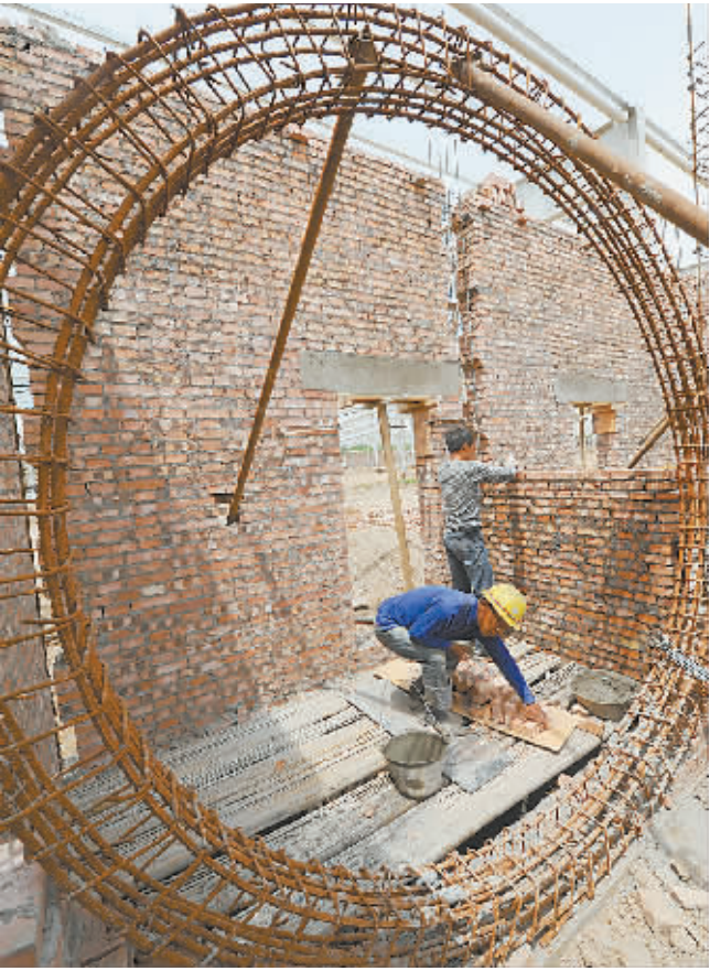
近日,施工人员在市海华纺织股份有限公司20万锭高档紧密纺纱二期项目工地施工。据悉,该项目总投资7.5亿元,目前一期10万锭紧密纺纱项目已部分投产,预计今年7月底可全面投产。
