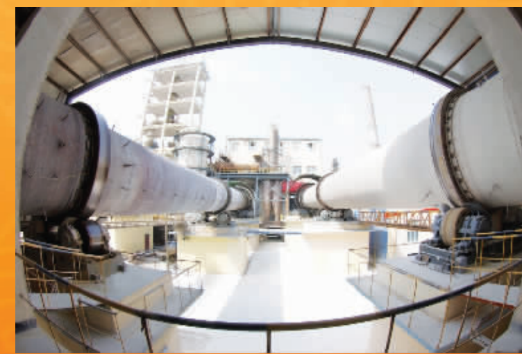
公司煅烧车间回转窑一角
