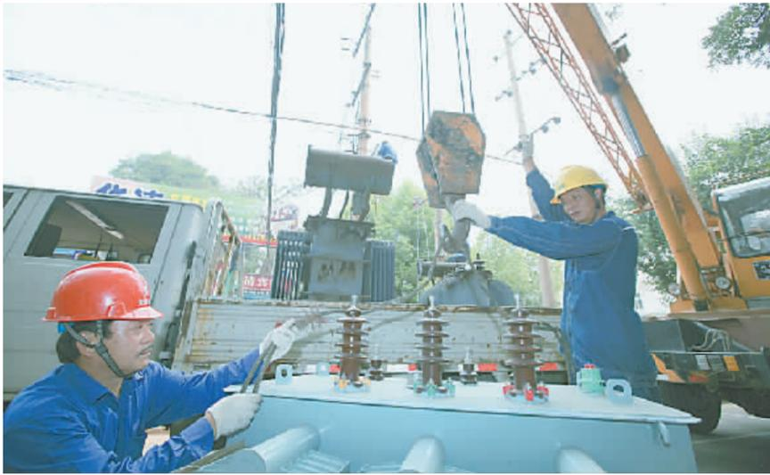
为进一步推进节能降耗，焦作供电公司组织人员将市区内高耗能变压器更换为新型节能产品——非晶合金电力变压器。据了解，该变压器空载损耗较传统变压器低80%左右，空载电流下降约60%，节能效果十分明显。图为7月21日，该公司员工正在安装新型变压器。(乔桥)
