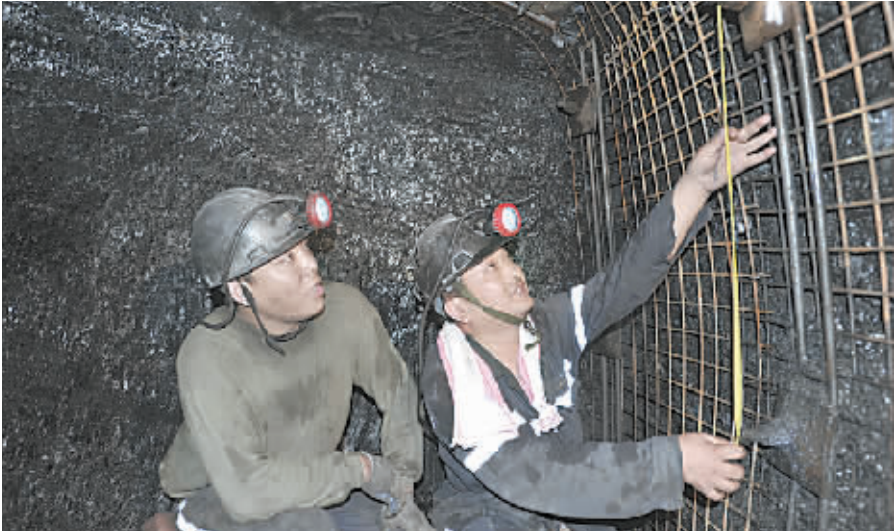
▲焦煤集团古汉山矿把作业流程标准化作为重中之重来抓，以此推动精细化管理上台阶。图为7月28日该矿综掘一队跟班领导在井下31掘进头对锚网支护按照标准化进行验收。
