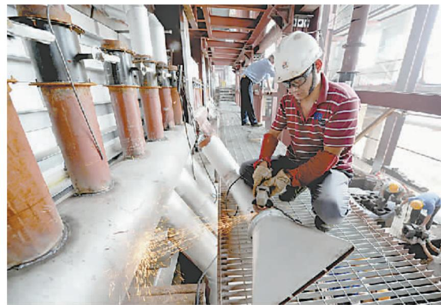
昨日, 河南思可达光伏材料股份有限公司4×700平方米超透太阳能光伏玻璃一期项目工地, 工人们正在新建的压延联合车间制作熔窑冷却风管。该项目位于沁阳市沁北产业集聚区, 是河南省重点项目, 项目总投资10.5亿元, 目前总投资6亿元的一期工程安装已接近尾声, 将于9月中旬点火试车。
