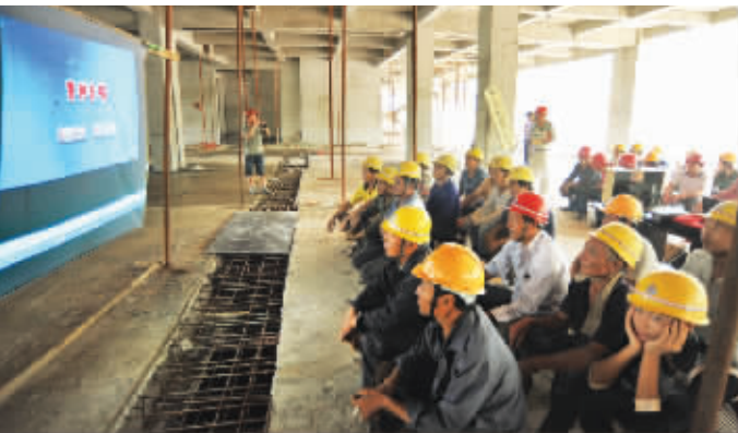
施工人员接受安全警示教育。
