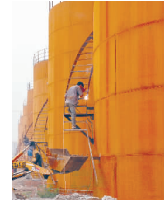
8月9日,市启瑞生物科技发展有限公司的建设人员正在对增塑剂成品储罐进行焊接。据悉,该项目总投资10亿元,产品可广泛应用于医药卫生、高档皮革制品等领域。建成投产,预计可实现销售收入25亿元,利税1.5亿元,安排就业600余人。徐恒峰 王琳 摄
