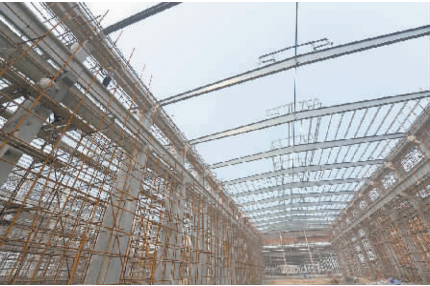
8月19日,广东兴发铝业年产10万吨高档铝型材深加工项目工地,工人们正在建设1.1万平方米的熔铸车间。该项目总投资10亿元,主要从事高档铝型材精深加工,分两期建设。该项目全部投产后,年可实现产值40亿元,创利税4亿元。目前,该项目首期7万平方米的生产车间主体已全部建成,正在进行管道敷设和设备基础建设。
