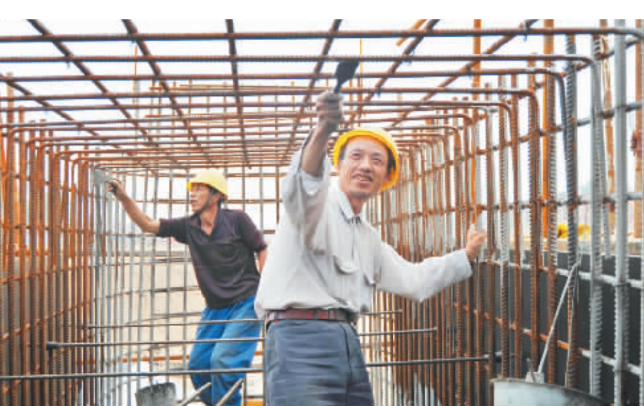
南水北调中线焦作Ⅰ段Ⅱ标普济河倒虹吸工程正在建设中。 本报记者 田建明 摄
