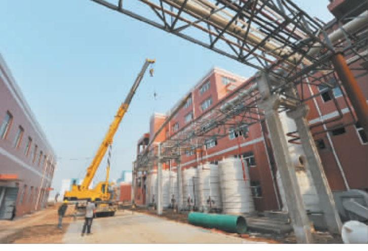
即将完成扩建投产的生物医药龙头企业——华兴公司新厂区。
