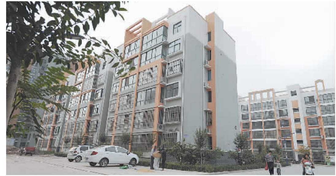
南水北调焦作城区段总干渠征迁共需建安安置房33.4万平方米，截至2010年6月，总干渠安置房全部竣工。目前，绝大多数群众已经入住新居。这是9月24日记者在解放区王褚街道西于村集中安置小区拍摄的镜头。 本报记者 杨 帆 摄
